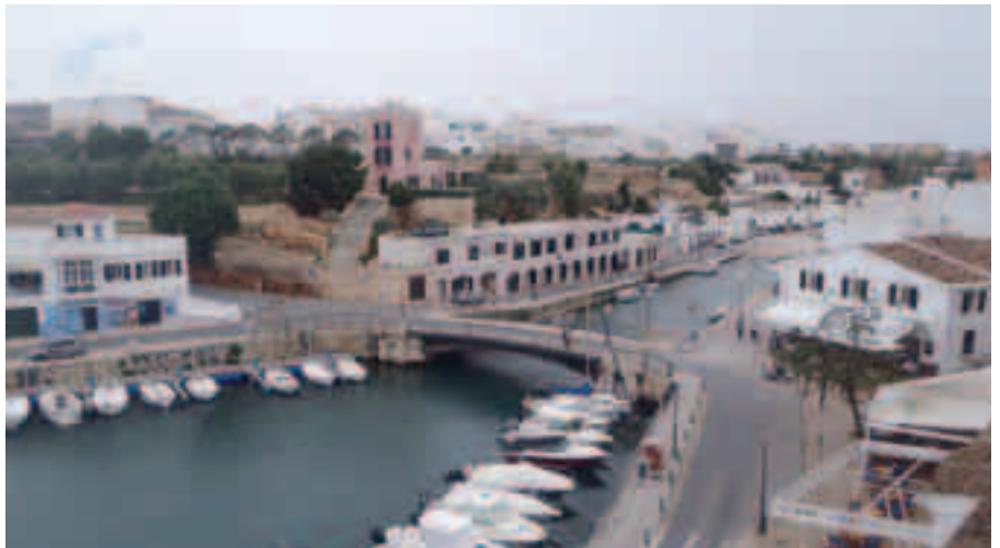
Sobre los arcos, la cofradía de Ciutadella y detrás el edificio de la antigua aduana.
